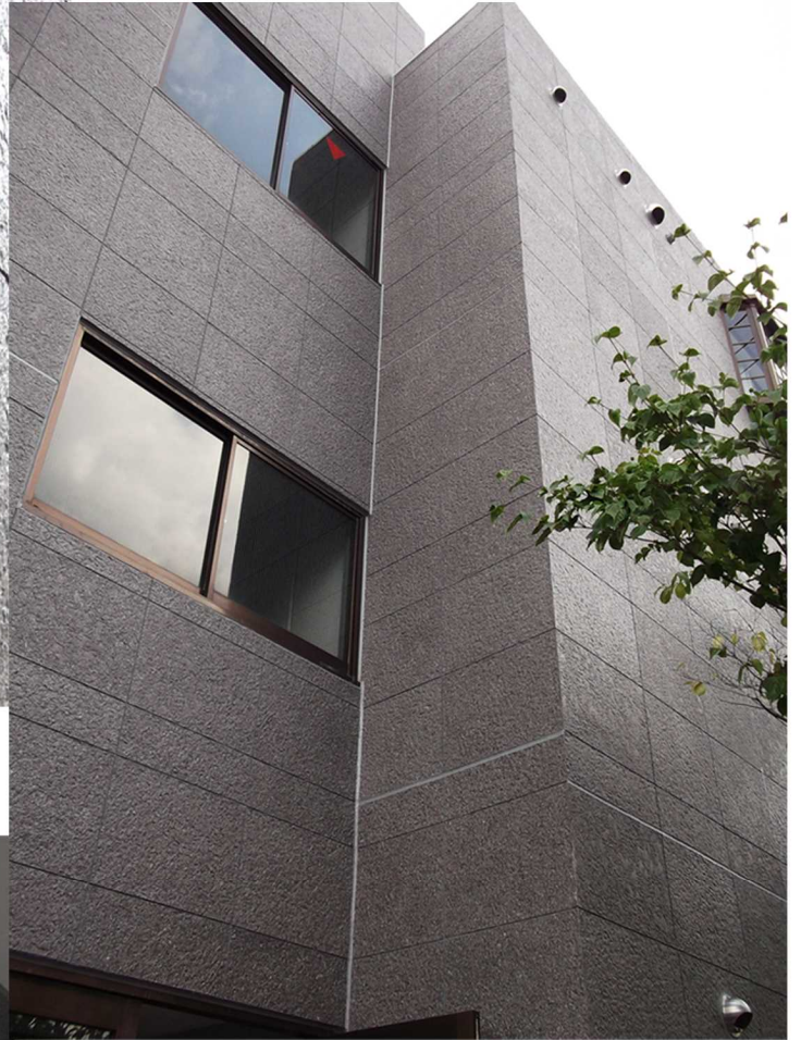
シートの裁断が容易なため、窓などのサイズに合わせるなど御案件ごとに割付が可能
