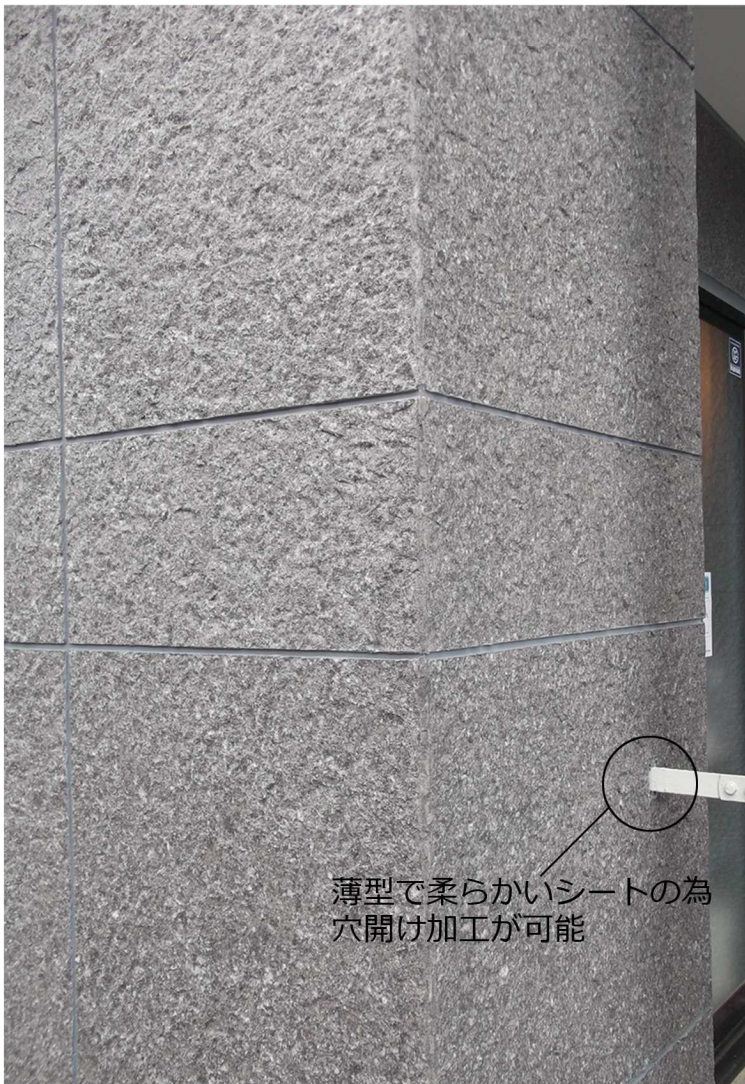
専用補修材により処理した出隅
